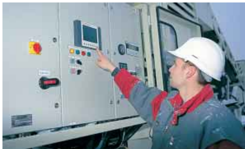
A2020 на дробильной установке Nordberg LT.
